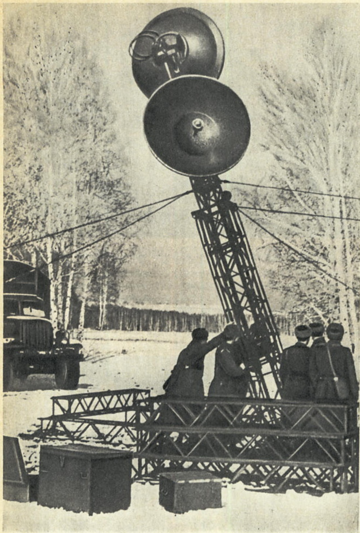
В условиях, максимально приближенных к боевым, экипаж радиорелейной станции устанавливает антенну
